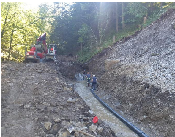
Abb. 4.3: Grabarbeiten Neufassung Gätteri (Foto L&H; 4.9.2023)
