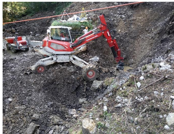
Abb. 4.4: Grabarbeiten Neufassung Gätteri (Foto L&H; 6.9.2023)
