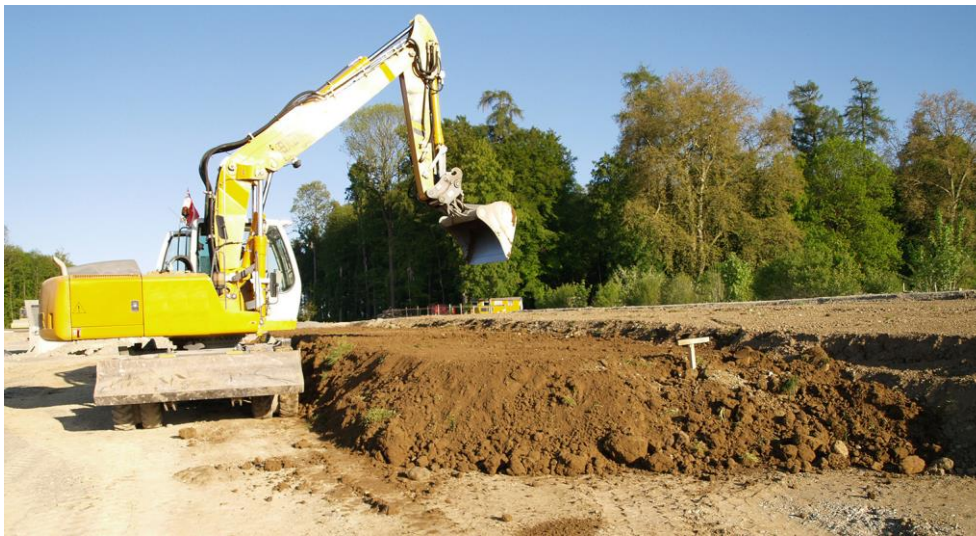
Abb. 37 > Wiederherstellung des Bodens in aufeinanderfolgenden Streifen in einem Arbeitsgang
