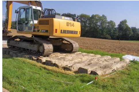
Abb. 34 > Baggermatratzen aus Rundhölzern
