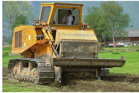
Abb. 30 > Bodenwiederherstellung mit Planierfraupe unter feuchten Bedingungen
