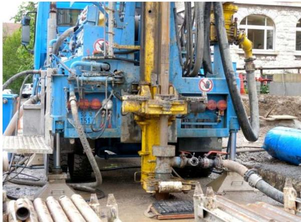
Abb. 1: Erdwärmesondenbohrung Bruggen, St.Gallen
