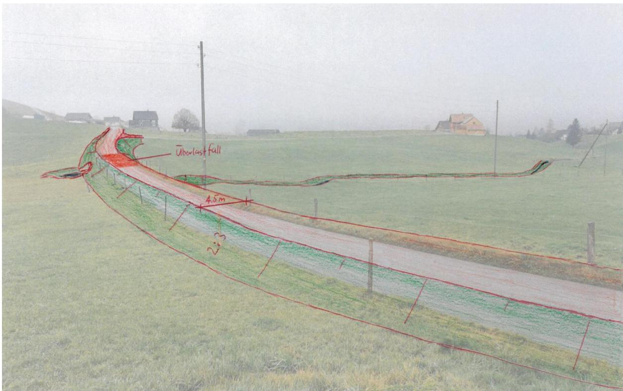
Abbildung 2: Visualisierung Hochwasserrückhaltebecken Hermes mit höherer Pöppelstrasse und Ausdolung.
