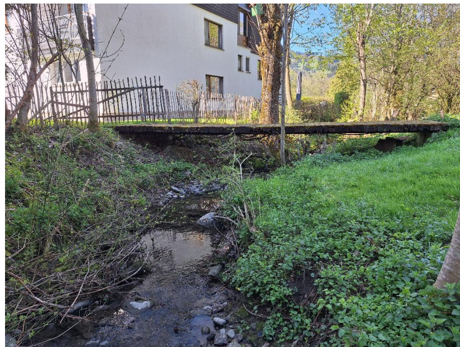
Bestehender Fussgängersteg, Blick in Flieβsrichtung
