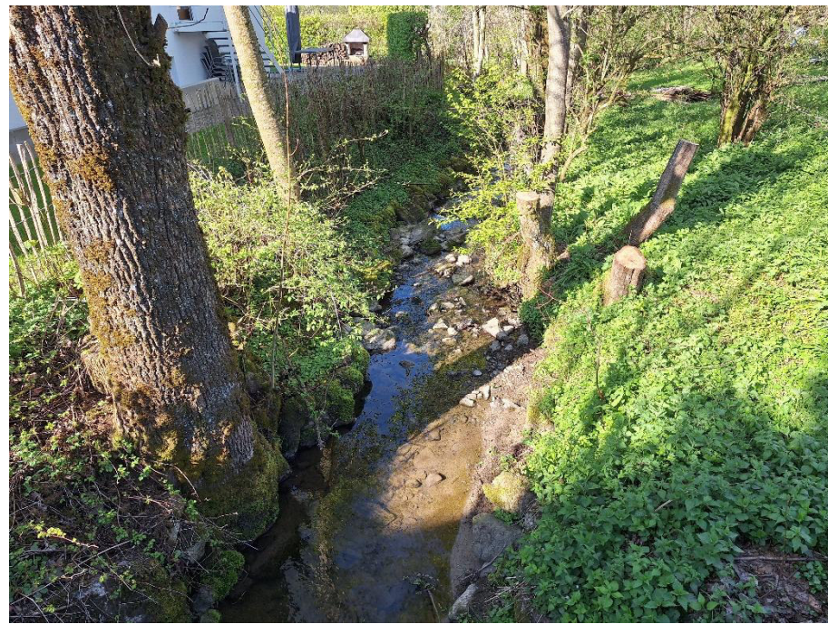
Blick vom Steg in die Fließrichtung
