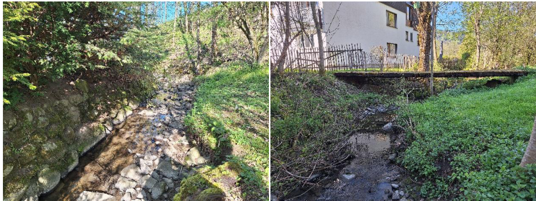
Abbildung 8: meist durchgehender einseitiger Längsverbau
